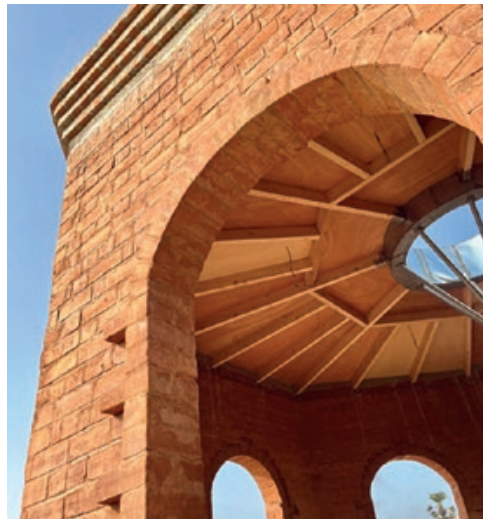
Maison en briques de terre crue, 2023, Sénégal – Marc Held architecte © Marc Held
