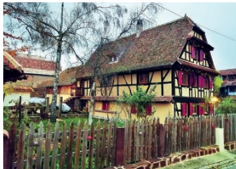
Façade après les travaux ©Loïc Cavalier
