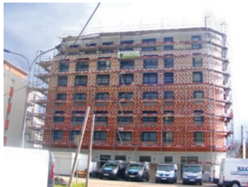
Vue du chantier, quai d'Issly © Ville de Mulhouse
