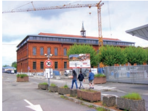
Chantier de réhabilitation du Bâtiment 36 depuis la rue Spoerry © Ville de Mulhouse
