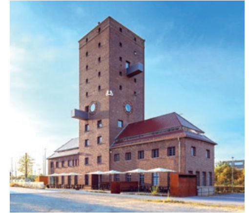
Tankturm — Außenansicht ©Thilo Ross
