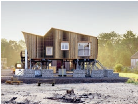
Gebäudeprototyp RoofKIT © Zoëy Braun
