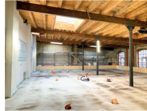
Umnutzung Tramdepot – Umbau Eicher Architekten © Esther Baur
