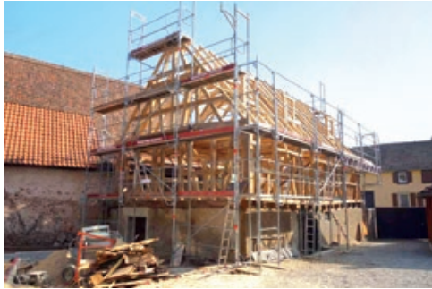
Reconstruction de la charpente et pans de bois ©Emmanuel Haacke
