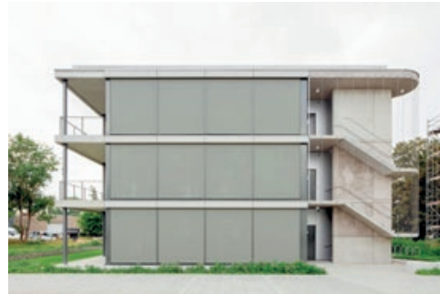
Bürogebäude TINA, Architekten - Studio Sozia © Kim Fohmann
