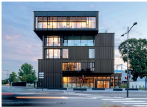
Le nouveau siège du Port autonome de Strasbourg, Rey + De Crécy architectes © Valérie Trégan
