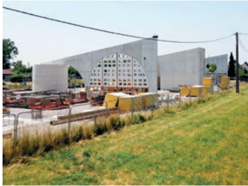
Chantier – juin 2023 ©N01 architecture
