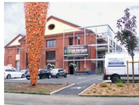
Vue du chantier de la fabrique côté rue de Bâle ©Ville de Mulhouse
