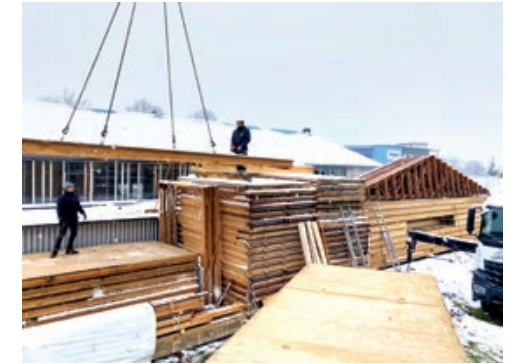
Déchargement des éléments de structure ©atelier bleu
