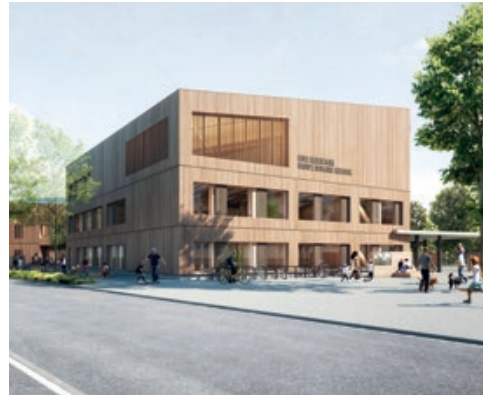
Le groupe scolaire Mentelin et sa structure bois ©MW Architectes
