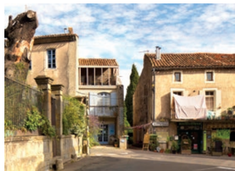
Surélévation d'une chambre d'hôtes en entrée de village à Montolieu dans l'Aude ©Atmosphériques Narratives
