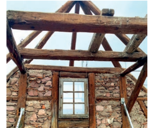
Travaux en cours en mars 2023 © Christophe Hurst
