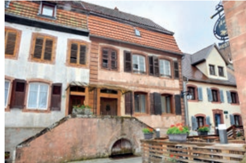
Façade avant les travaux ©Rose Schreiber
